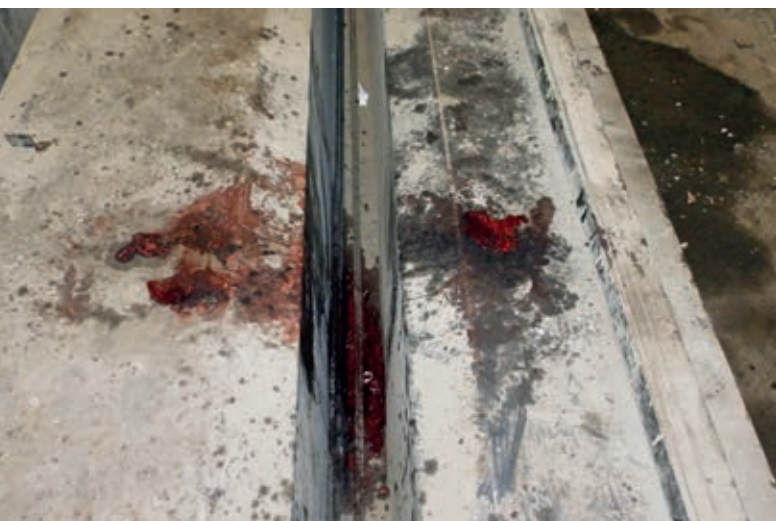
Fot. 3, 4. Na pierwszym planie metalowa forma ze śladami krwi w miejscu, gdzie poszkodowany spadł po uderzeniu belką oporową
